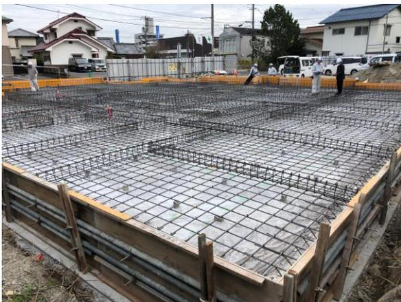
11月9日基礎工事前の配筋検査（基礎の鉄筋が設計通りに配置されているかの検査）が行われ、結果は合格でした。16日からは基礎コンクリート注入工事に進ことが確認されています。
